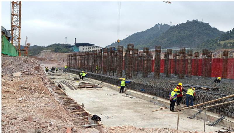
2022年11月，工人在焦炉底板捆扎钢筋。
